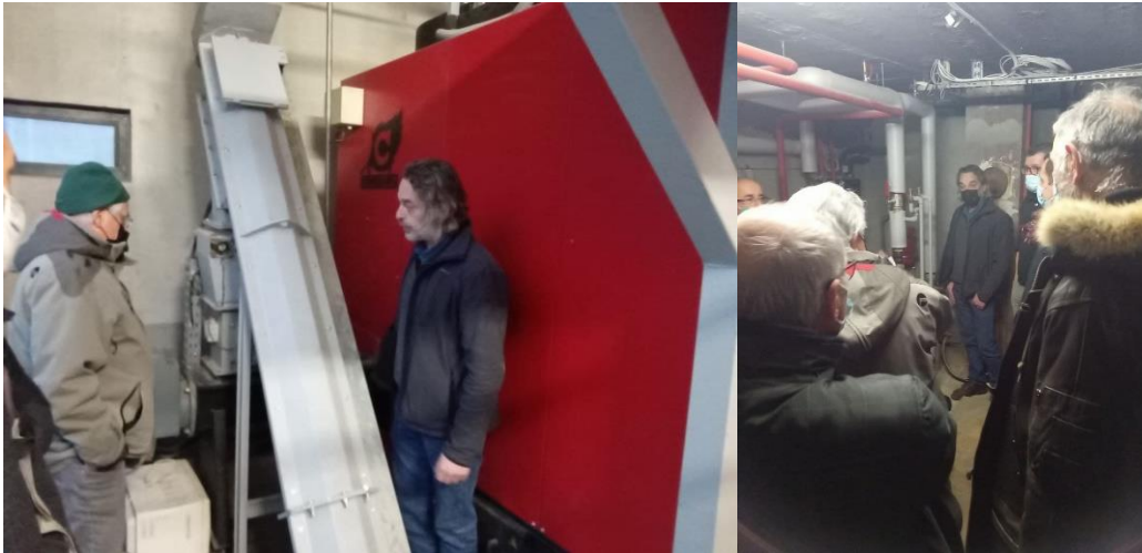
Visite du réseau de chaleur de Yenne, le 14 décembre 2021
