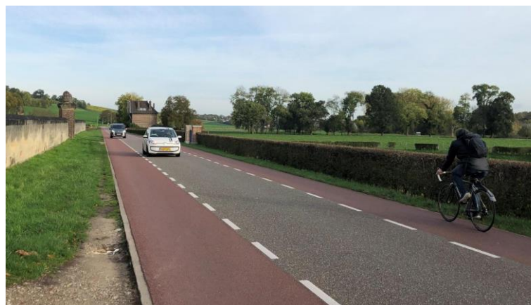
Voie centrale banalisée avec accotements en résine
