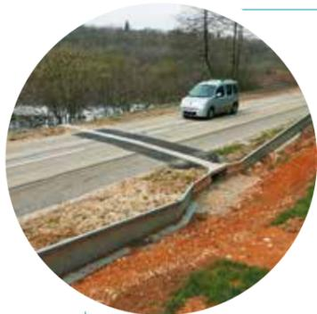
A l'automne 2019, le Conseil départemental de Savoie a construit sur ce site un passage à petite faune destiné à se substituer aux actions bénévoles de ramassage réalisés pendant une décennie. Les travaux ont consisté à la réalisation de caniveaux bétons et à la pose de profils permanents de canalisation. Il a fallu
