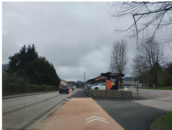
Voie verte en cours de finalisation en rive Ouest du Lac d'Aiguebelette,
