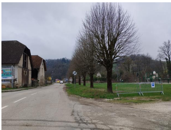
Lépin-le-Lac : cheminement piéton pour rejoindre le Gué-des-Planches peu qualitatif (étroit et en mauvais état)
