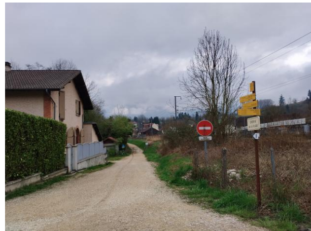
Cheminement le long de la voie ferrée pour accéder à la gare de Lépin, permettant un accès plus sécurisé aux cyclistes
