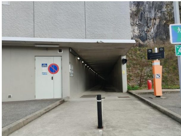
Tunnel dédié aux cycles pour rejoindre l'agglomération aixoise et chambérienne
